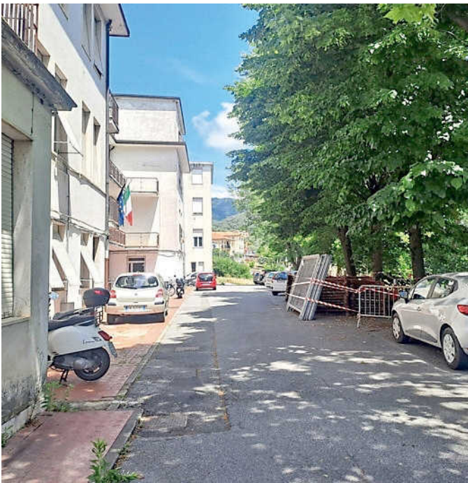
Una porzione di cortile del San Nicolò con l'area di cantiere
