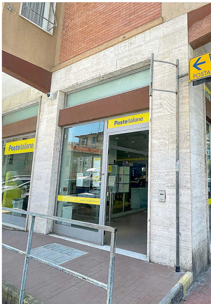
L'ufficio postale di via Monteverdi
