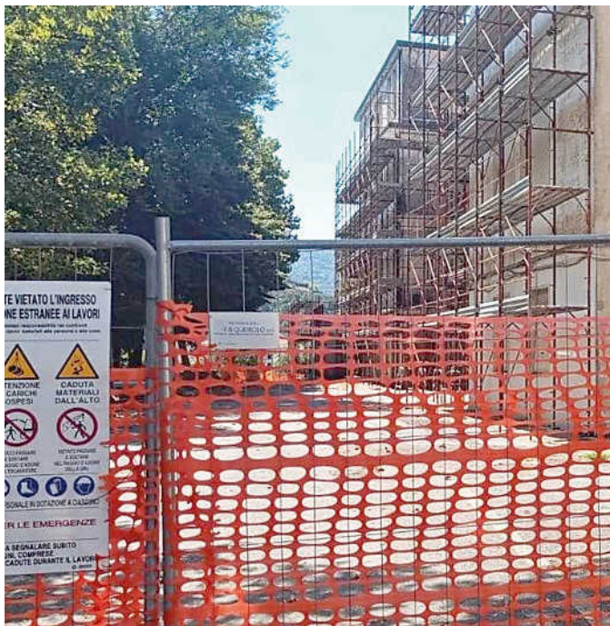
Alcuni dei ponteggi installati all'ospedale San Nicolò di Levanto
