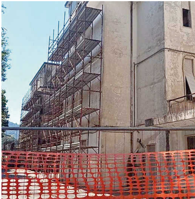
I ponteggi installati all'ospedale San Nicolò di Levanto
