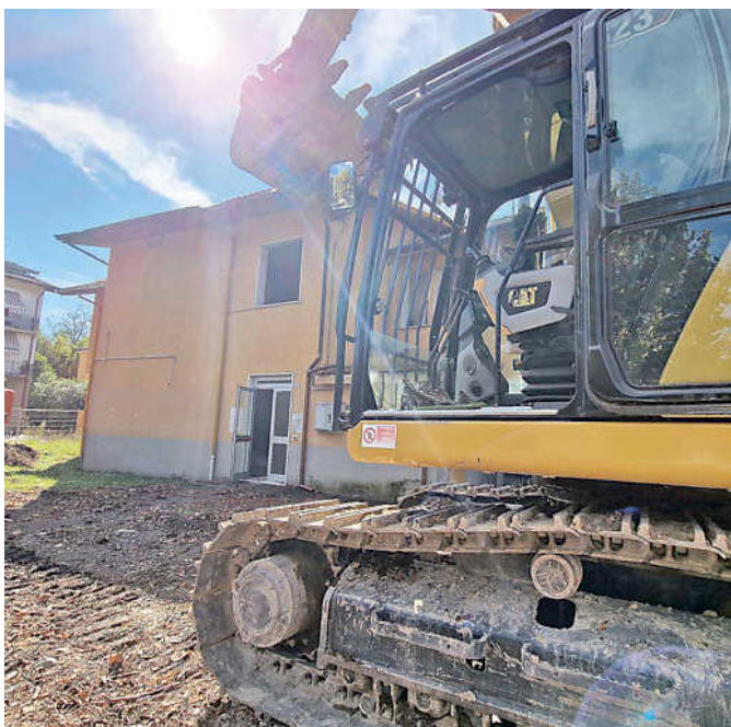
Una delle ruspe che si occuperà dei lavori
