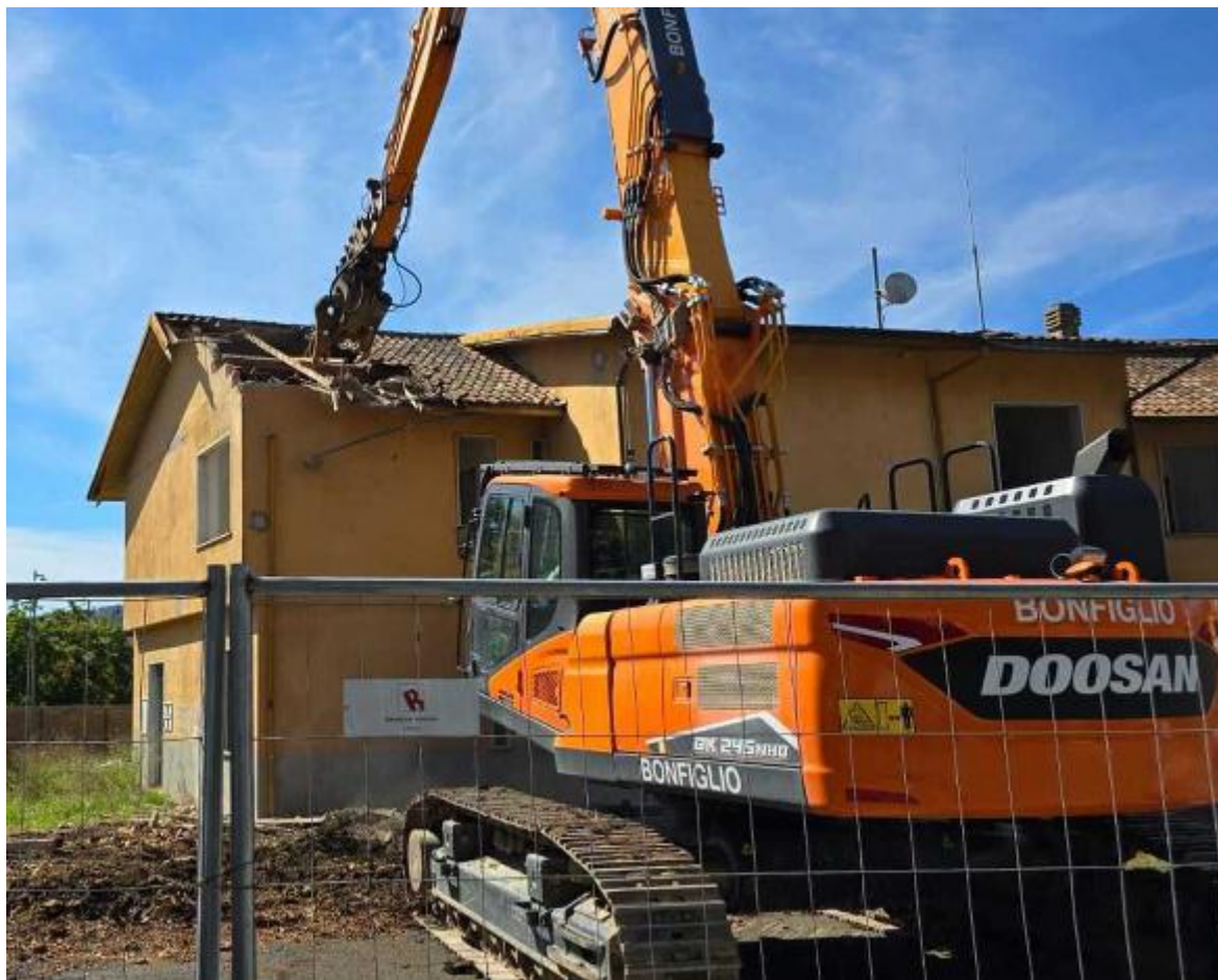
La demolizione dell'ex delegazione comunale di Ceparana: al suo posto sorgerà il nuovo centro sociosanitario di Asl5
