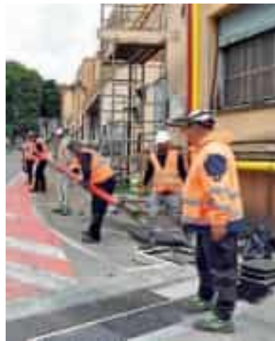
▲ Work in progress I lavori dentro il Gaslini
