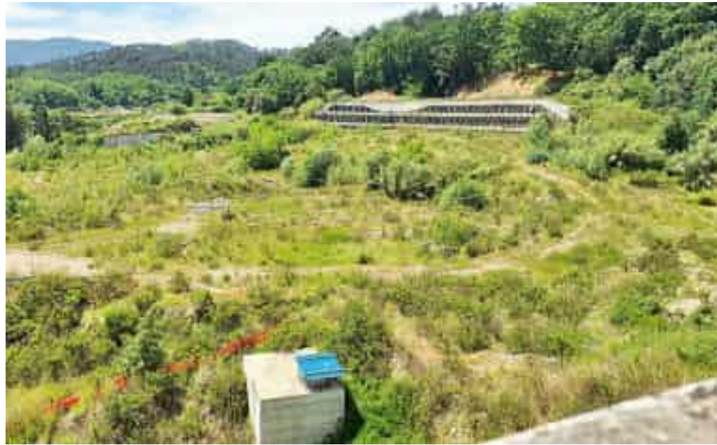
Il cantiere del nuovo ospedale Felettino
