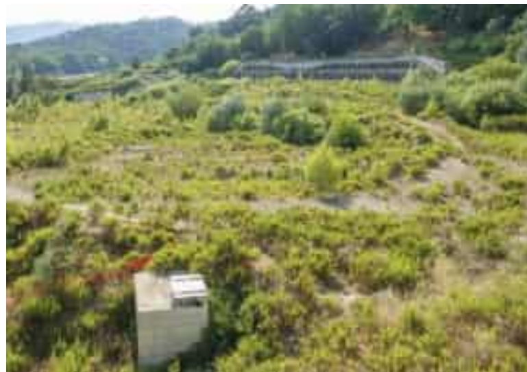
Lo stato in cui versa attualmente il cantiere dell'ospedale Felettino
