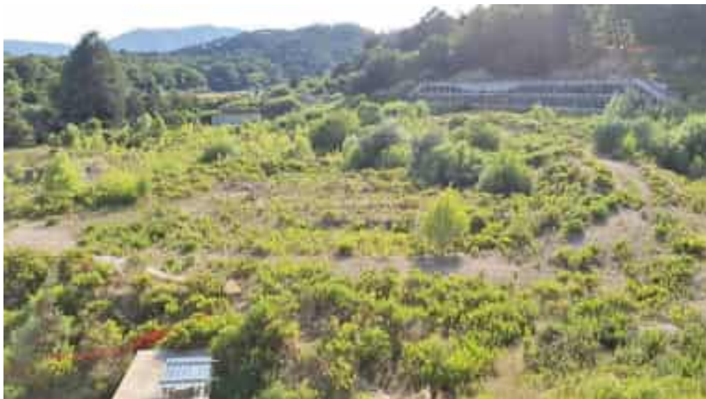
Lo stato attuale del cantiere del nuovo ospedale Felettino
