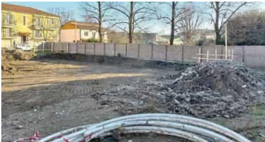
Il cantiere della Casa di comunità a Bolano
