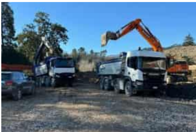
Ogni giorno vengono effettuati almeno 45 viaggi dal cantiere del nuovo ospedale
