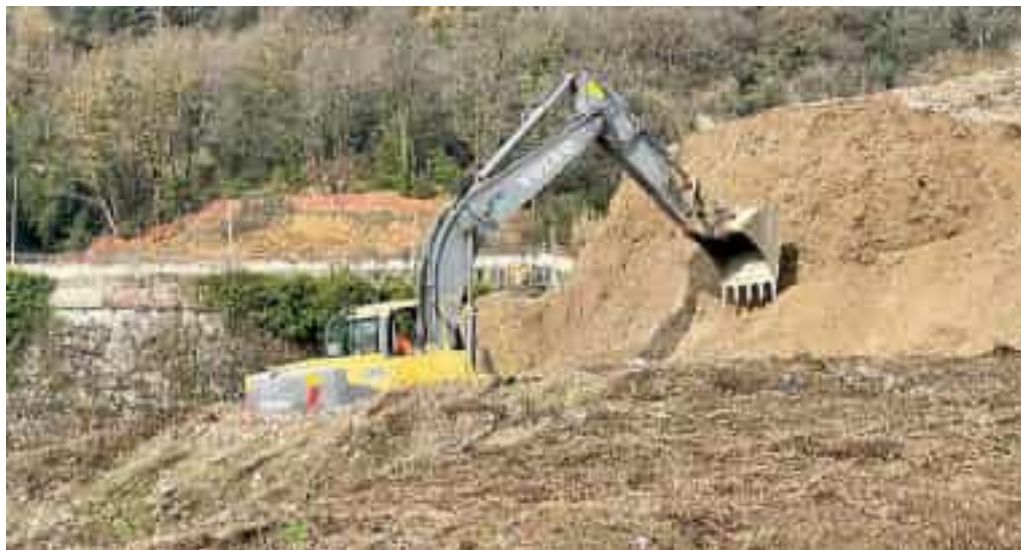
Primi colpi di ruspa nell'area dove dovrebbe sorgere l'ospedale
