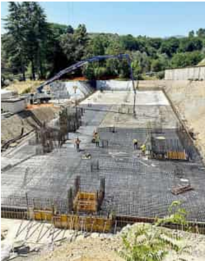
I lavori nel cantiere del Felettino ora viaggiano spediti
