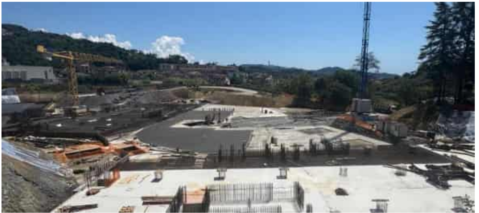
Ad oggi sono state completate le platee di fondazione di due delle quattro stecche del futuro ospedale e le impermeabilizzazioni radon sulle superfici di fondazione
