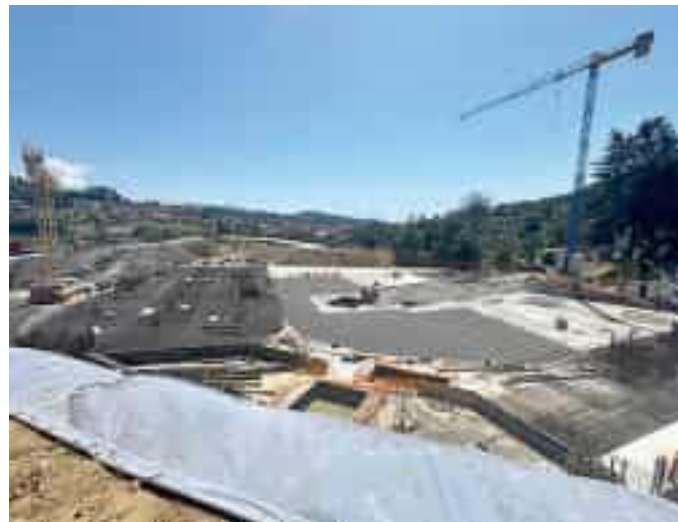
Il cantiere per la costruzione del nuovo ospedale Felettino
