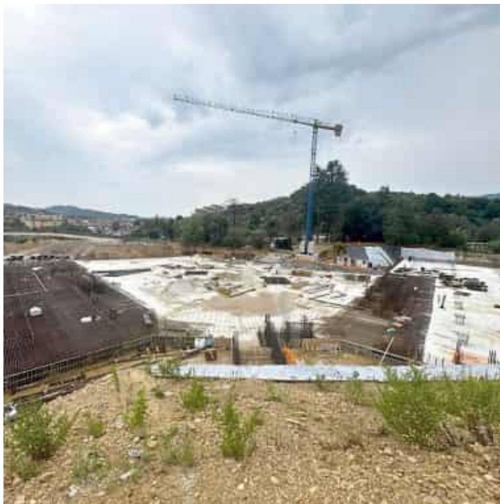
Parte del cantiere del nuovo ospedale Felettino
