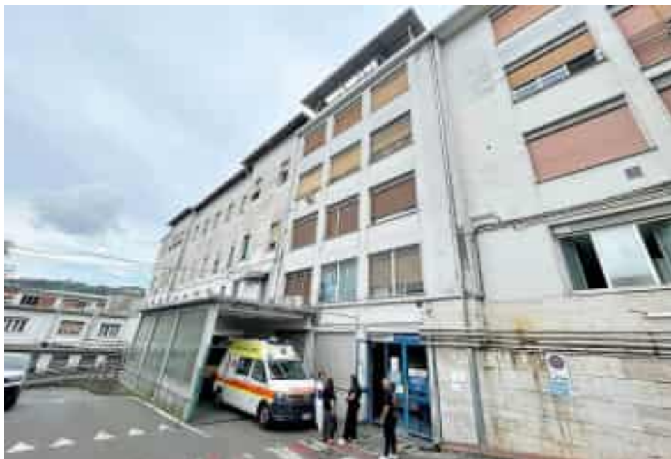
La struttura del Pronto soccorso del Sant'Andrea necessita di un restyling in attesa della realizzazione dell'ospedale del Felettino
