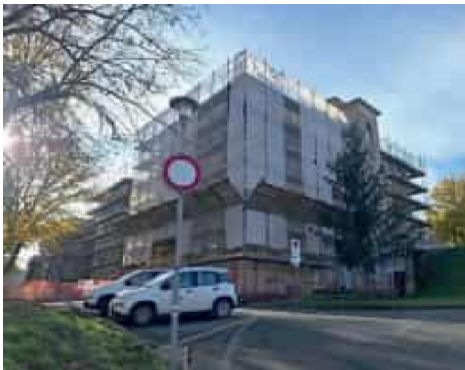
I lavori di messa in sicurezza al San Nicolò
