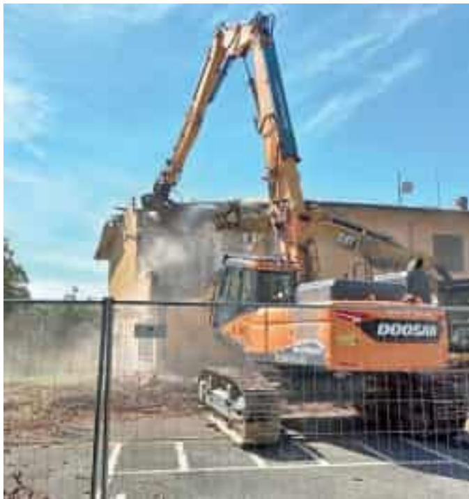
I lavori di demolizione a Ceparana
