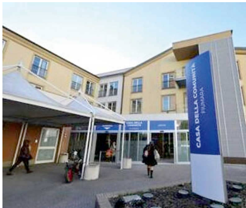
La Casa di Comunità aperta alla Fiumara
