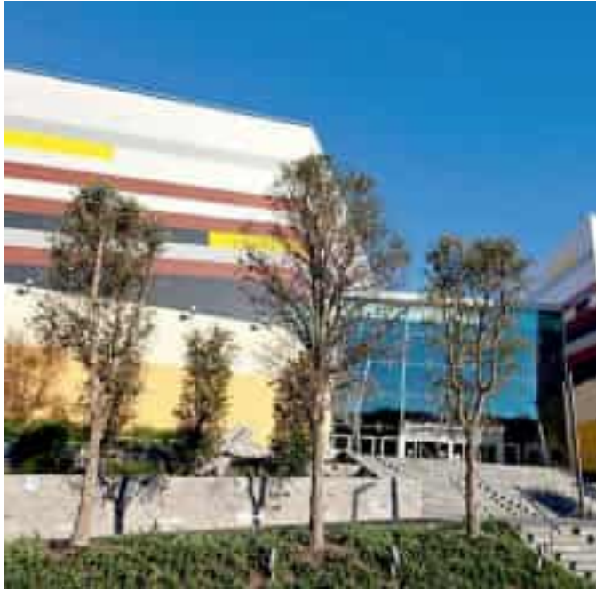
L'ingresso del centro commerciale Le Terrazze
