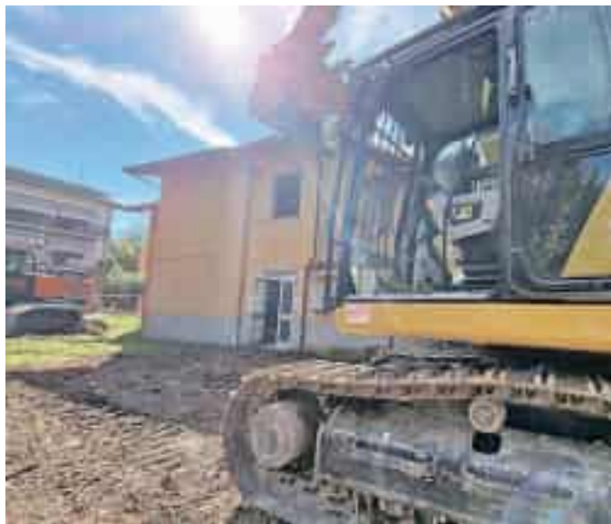
I lavori alla casa di comunità di Ceparana
