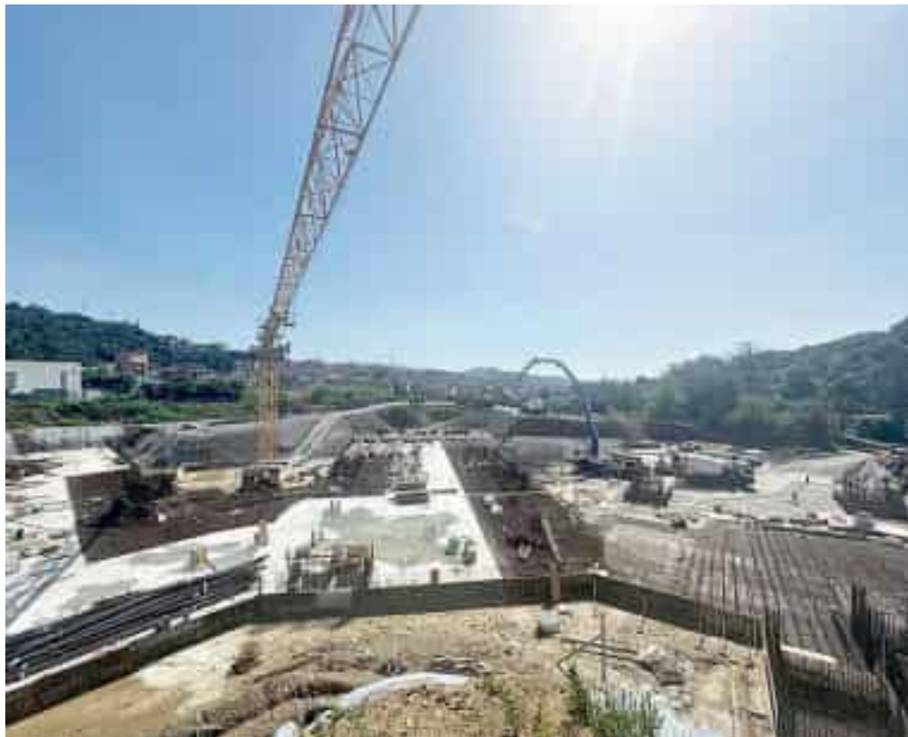
Lavori nel cantiere del nuovo ospedale della Spezia, al Felettino
