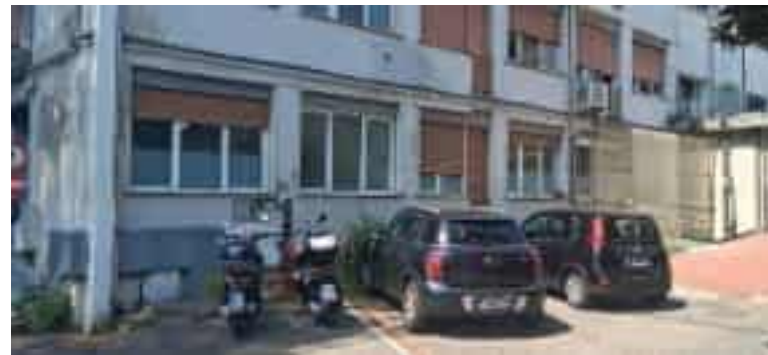
L'ala dell'edificio Da Pozzo in cui sono iniziati i lavori per il nuovo Pronto soccorso
