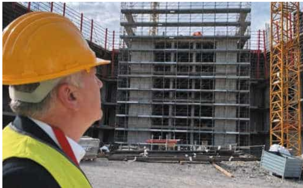
Il sindaco Pierluigi Peracchini osserva il cantiere del nuovo ospedale del Felettino
