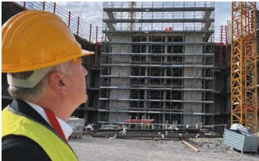
Il sindaco Pierluigi Peracchini osserva il cantiere del nuovo ospedale del Felettino
