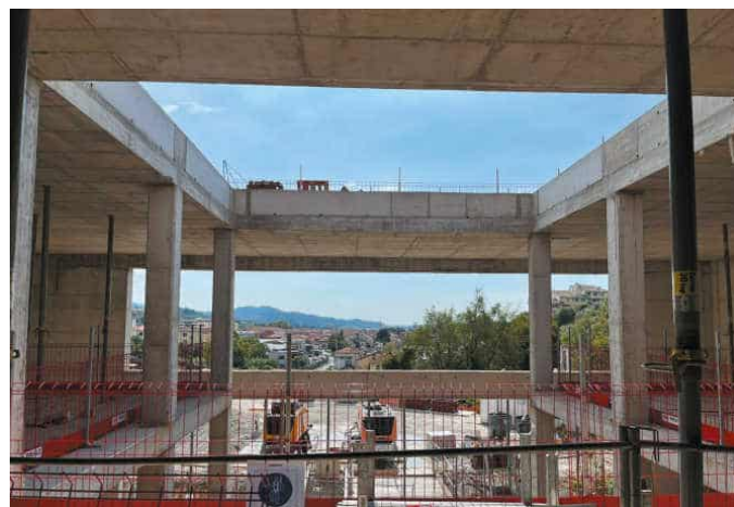
L'ultimo solaio realizzato dai costruttori
