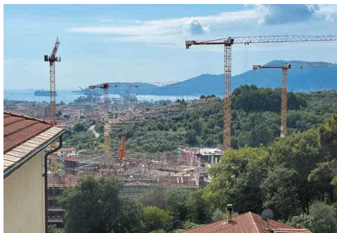
Una veduta dall'alto del cantiere
