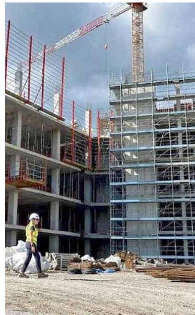
← Il cantiere alla Spezia per realizzare il nuovo ospedale Felettino. Fine lavori prevista nel 2028
